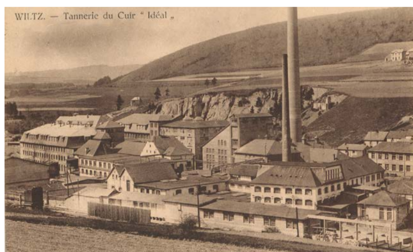
Damals: Die Ideal-Lederfabrik in Wiltz. Schornstein, ein Bürogebäude und vor allem das Portal, an dem 1942 Arbeiter aus Wiltz dem Nazi-Okkupanten die Stirn boten, bleiben erhalten. Weiter historische Fotografien sind auf industrie.lu zu finden.
