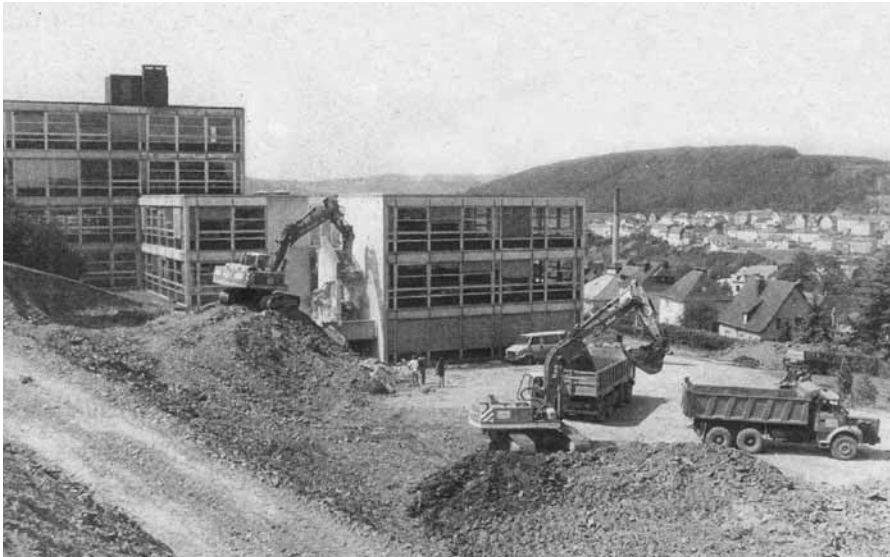
Die Erdarbeiten zum Ausbau des Lyzeums kommen zügig voran
