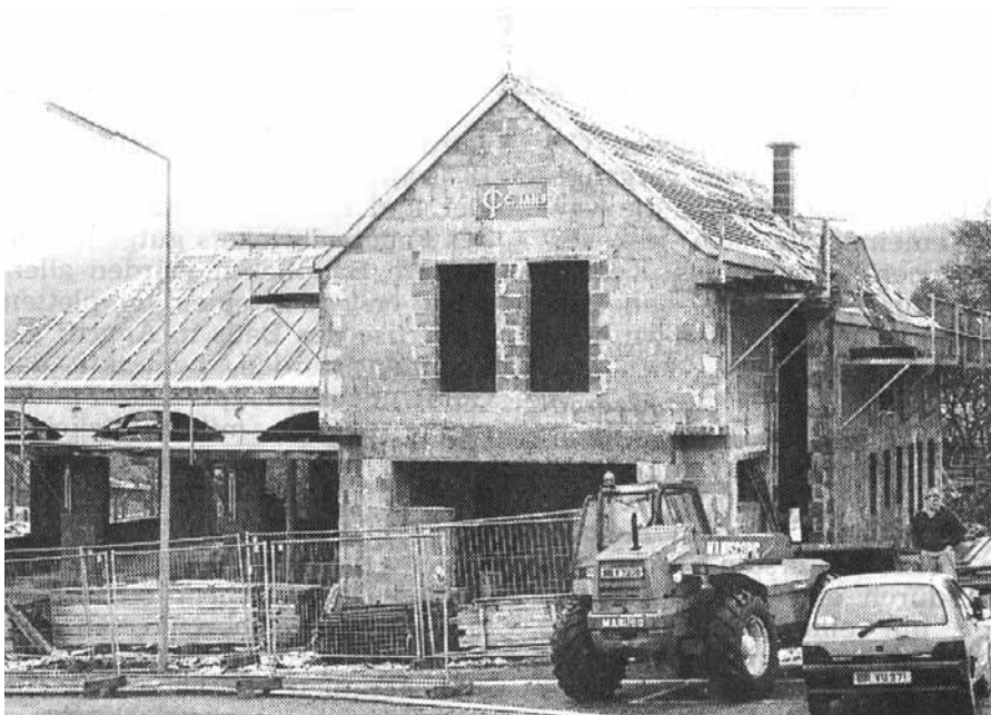
Der Rohbau des Home St Sébastien ist fertiggestellt
