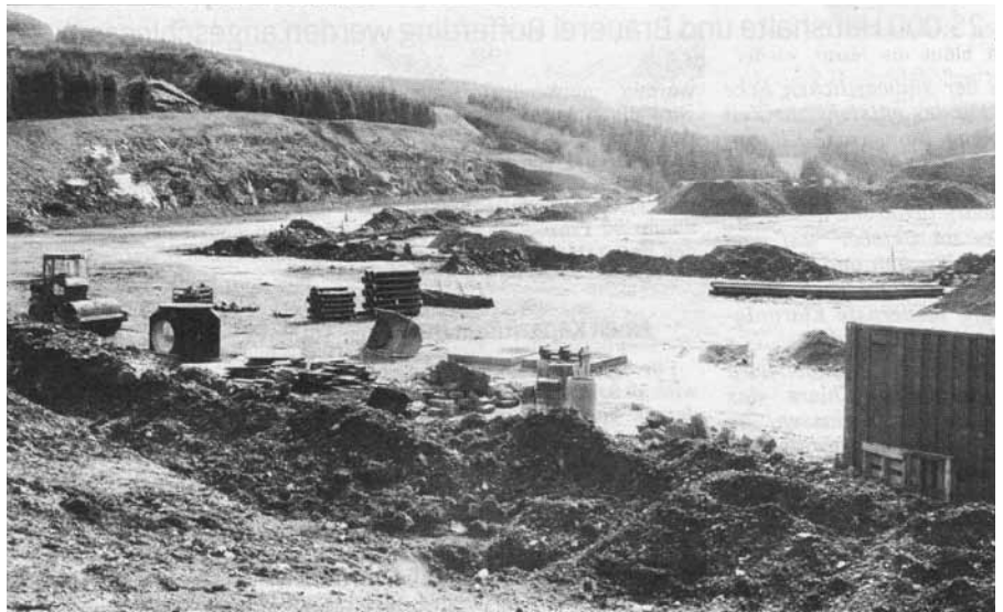
Die Arbeiten in der regionalen Industriezone haben begonnen
