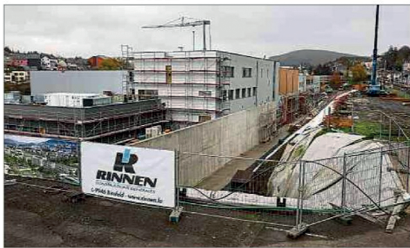
Die Arbeiten am neuen Schulcampus sind bereits weit vorangeschritten.
