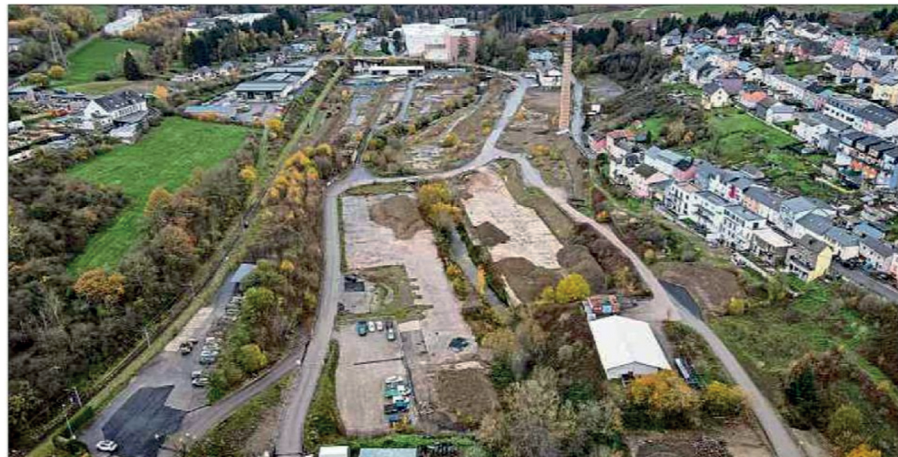
Das Wohnungsbauprojekt „Wunne mat der Wooltz“ ist das größte und vielfältigste Projekt, das derzeit und über die kommenden Jahre hinaus in Wiltz umgesetzt wird. Fotos: Gerry Huberty
