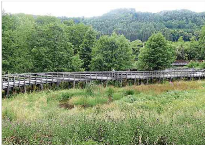
Der aus massivem Eichenholz gefertigte Ponton ist 77 Meter lang und ruht auf 52 Pfeilern. Der Bau war nötig, um ein Sumpfgbiet auf möglichst naturschonende Art überqueren zu können. Foto: Marc Hoscheid
