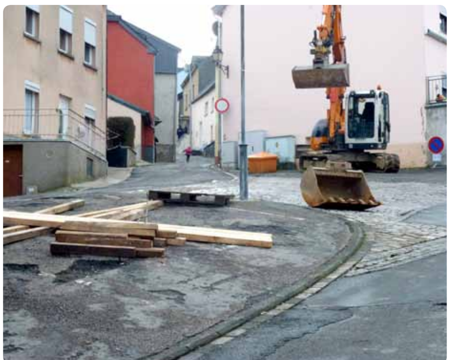
Beginn der Arbeiten in der Rue des Charretiers.
