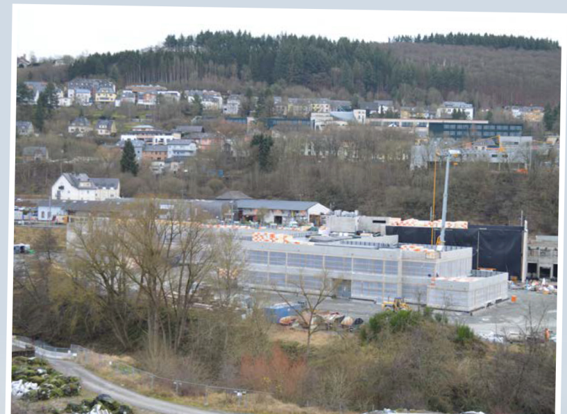
Allein 23,2 Mio. Euro fließen in die Fertigstellung des Bildungscampus „Géitz“, der für die Rentrée 2023 seine Türen öffnen soll
